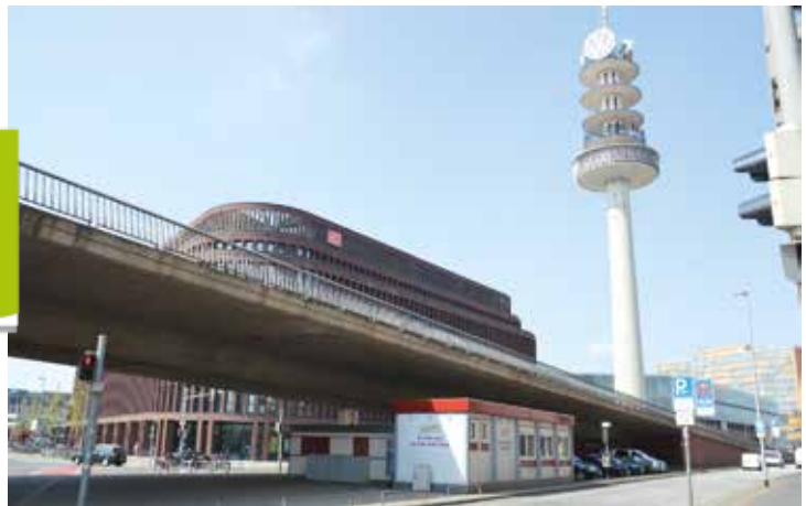
Der Bauwagen unter der Raschplatzhochstraße
