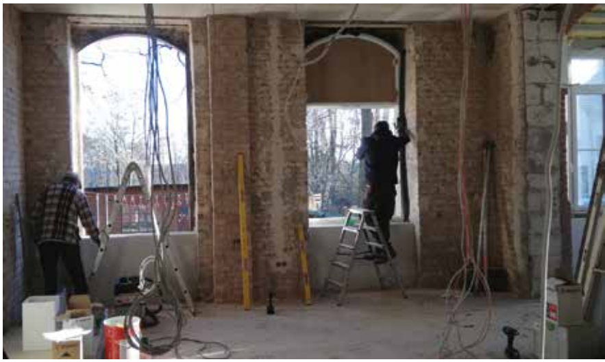
Handwerkliche Arbeiten im Haus der Hoffnung für die nächste Wohneinheit
